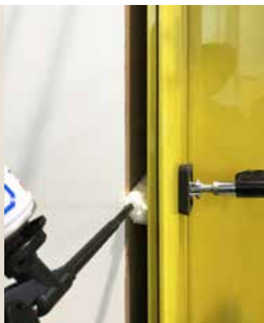
Kotvenie pomocou montážnej peny
