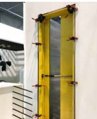
Príprava na montážnu penu
